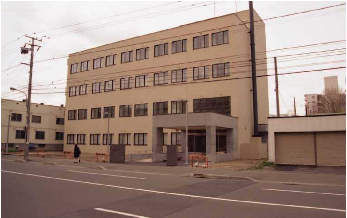
「写真1：引越し前の仮図書館全景」
